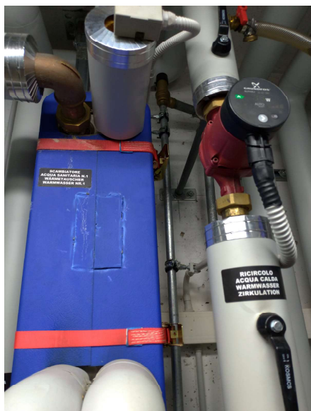
Fig. 2 - particolare di uno degli scambiatori e del condotto di ricircolo acqua calda sanitaria con relativa pompa
